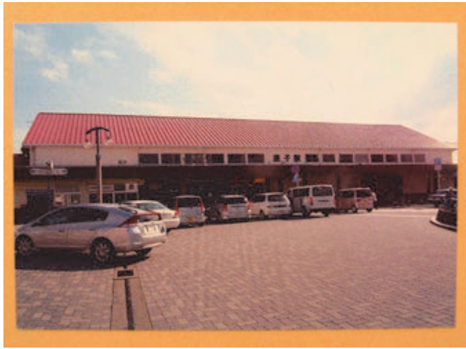
図 25 銚子駅 3 代目駅舎 戦後 1948 新築されたが、現在は 4 代目駅舎に代わっている。
